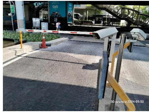
กล้อง CCTV ทางเข้า-ออก และระบบ ประตู Key card เข้า-ออก
