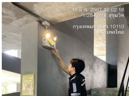
ตรวจสอบระบบไฟฟ้าฉุกเฉิน
