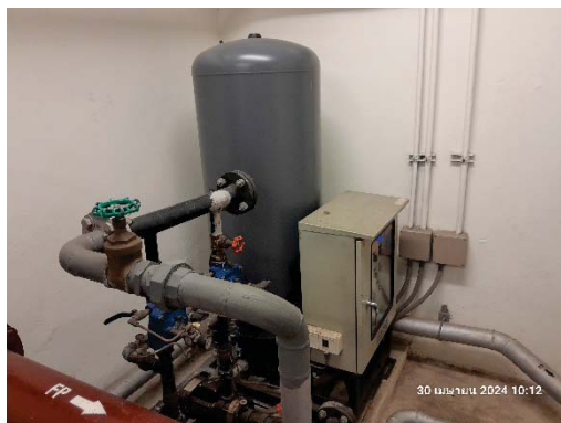
เครื่องสูบน้ำขึ้นดาดฟ้า
