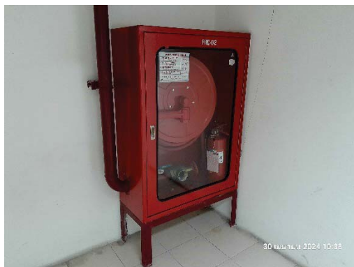
ท่อยื่น และตู้เก็บสายฉีดน้ำดับเพลิง
